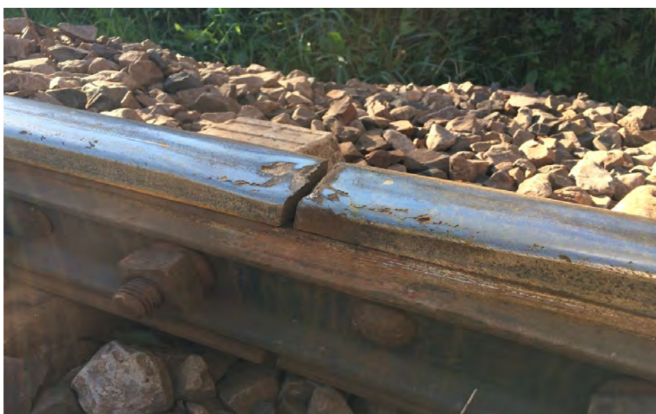
Figura 6 – Martelamento de junta de dilatação (Planta).
