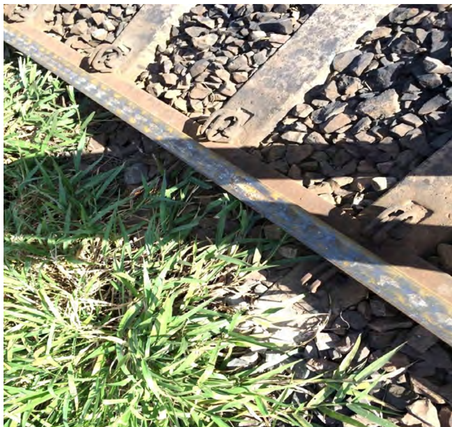
Figura 4 – Desgaste ondulatorio do trilho.
