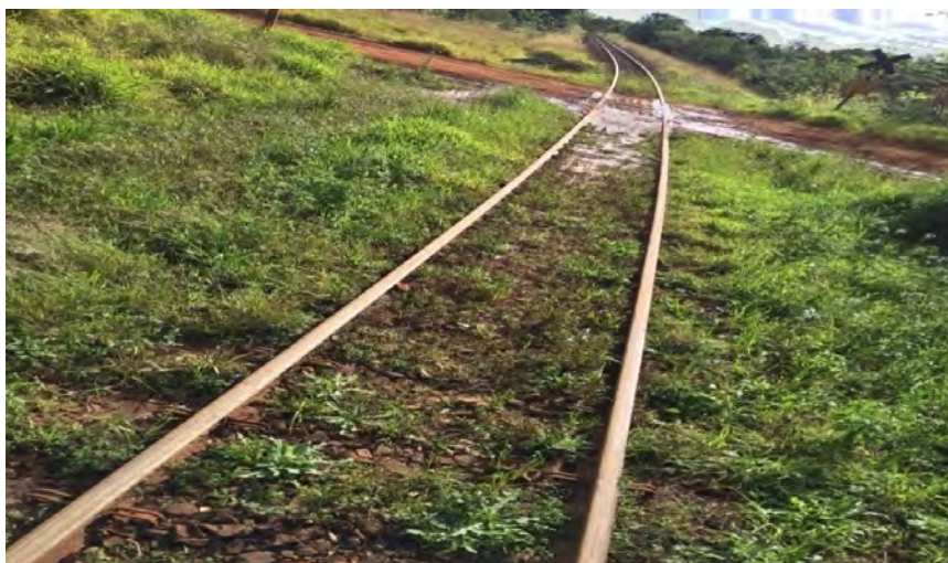
Figura 1 – Crescimento de Vegetação entre os trilhos e seus arredores.
