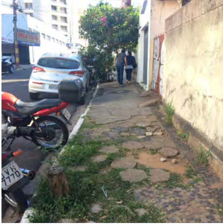
Figura 4 – Buracos e altura livre < 2,10 m.
