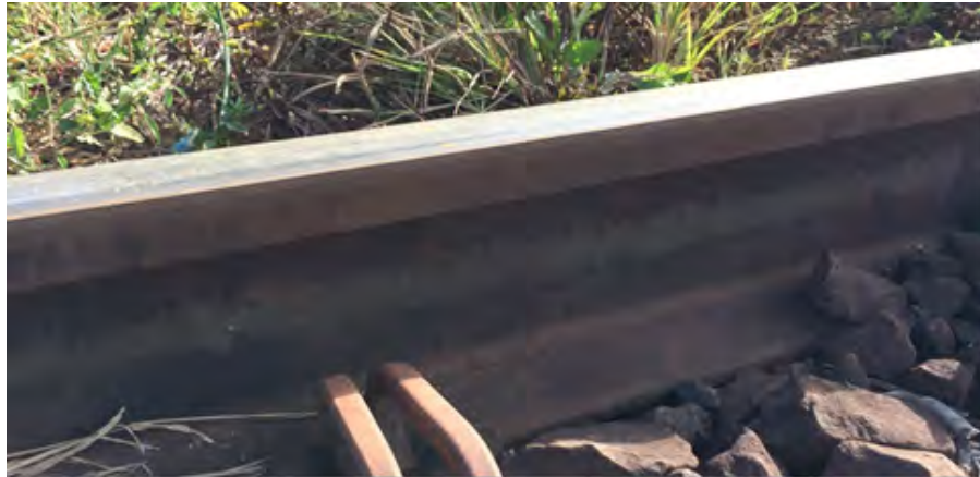
Figura 3 – Desgaste lateral do trilho por material rodante.
