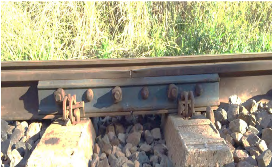
Figura 5 – Martelamento de junta de dilatação (Vista).
